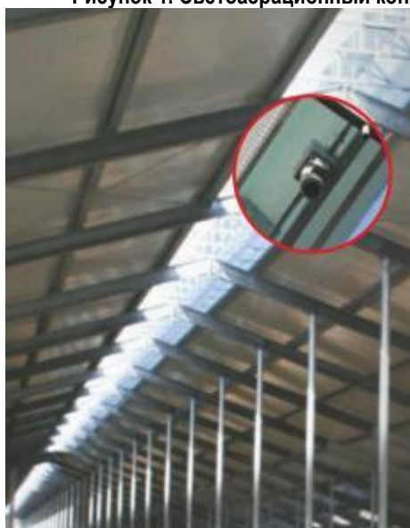
Рисунок 2. Место установки электропривода для регулировки вентиляционного зазора
